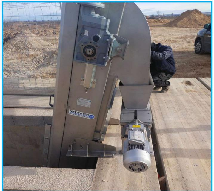
Instalamos UNA reja de gruesos SolidTech® Nw30 en canal de obra civil, ancho de canal 1200mm, alto de canal 4200mm, altura de descarga 1000mm, para tratar un  $Q=600\text{m}^3/\text{h}$ , luz de paso 15mm, material en Acero Inoxidable en calidad AISI-304, con la descarga en nuestro sinfín transportador ScrewTech® Nw80.160.
