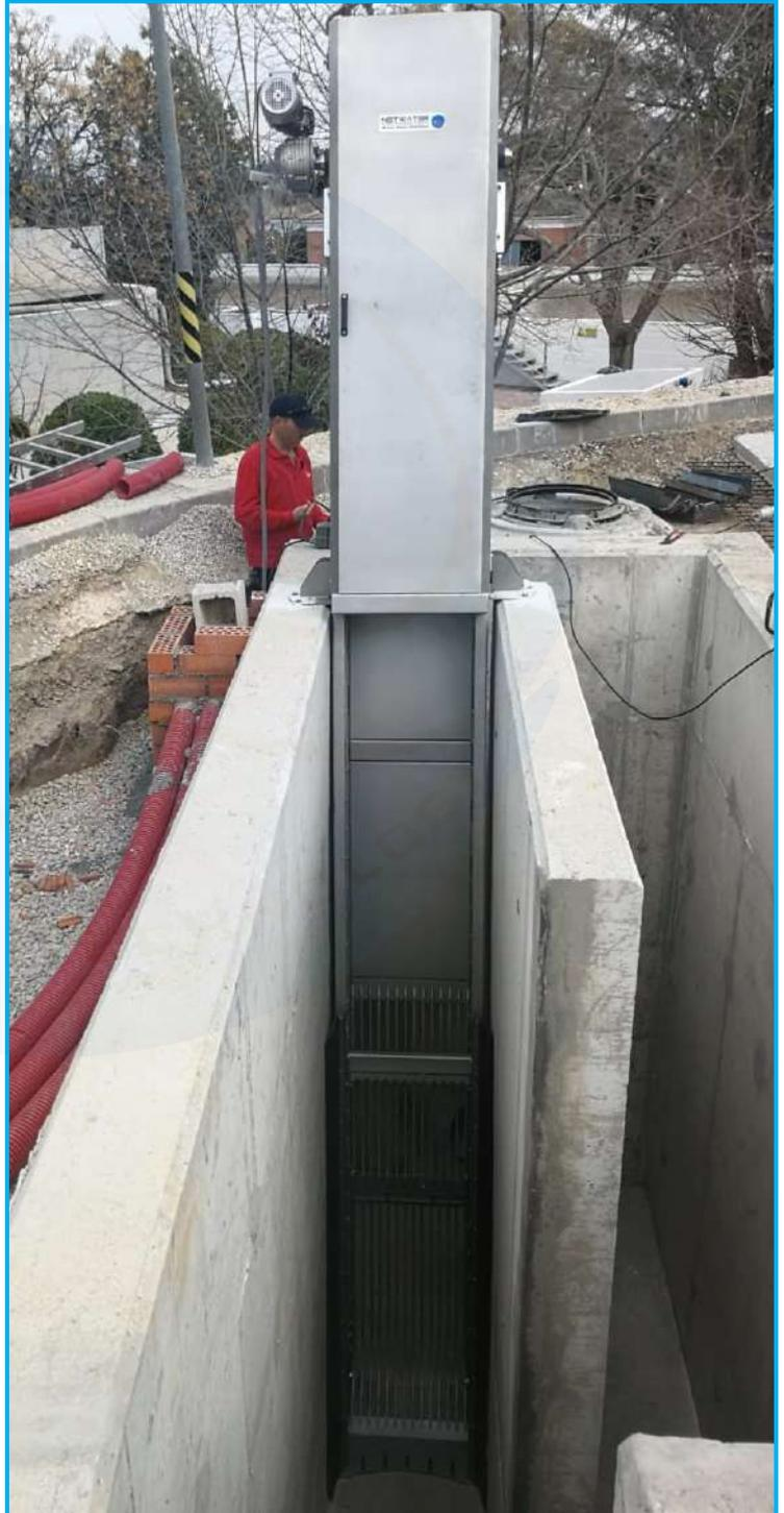
Instalamos UNA reja de gruesos SolidTech® Nw30 en canal de obra civil, para tratar un  $Q=1460\text{m}^3/\text{h}$ , luz de paso 30mm.
