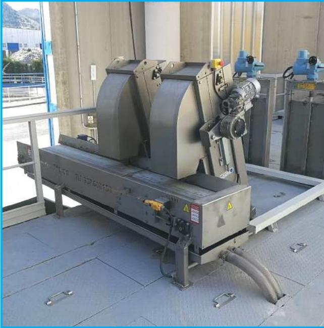
Instalamos DOS rejas de gruesos SolidTech® Nw30 en canal de obra civil, para mejorar la eficiencia del proceso de pretratamiento,  $Q=508\text{m}^3/\text{h}$ , luz de paso 12mm.
